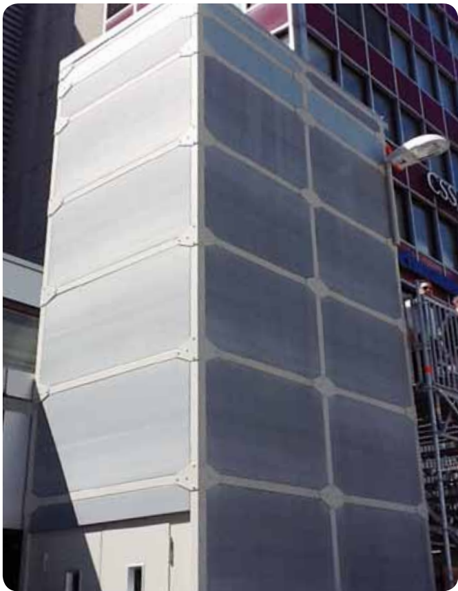
Ascenseur de chantier avec carreaux de tôle en tôle zinguée, structure de gaine basée
