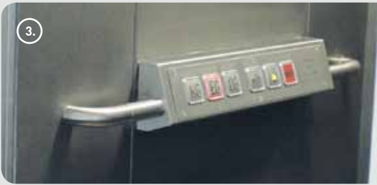
1. MRLH avec portes cabine automatique 2. MRLH vue intérieur de la cabine 3. MRLH unité de commande pupitre selon les normes handicapé dans la main courante
