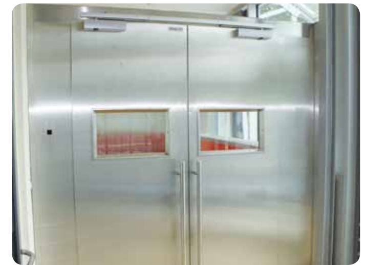
Zweiflügelige Tür aus V2A: innenliegende Bänder, rechteckige Fenster, Stangengriff, mit Brandschutzschließer (mit Schließfolgeregelung)
