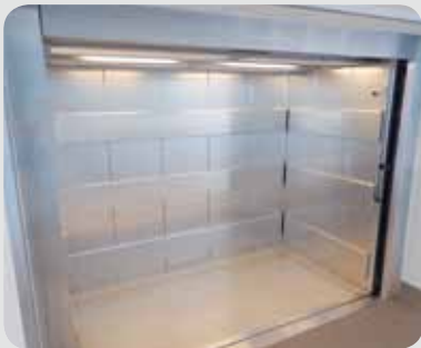
Boden mit PVC-Noppenbelag, Kabinenwände aus Edelstahl (V2A), Rammschutz aus Hartholz mit V2A-Ummantelung (dreiseitig, dreireihig), Decke mit Lichtrastrer weiß
