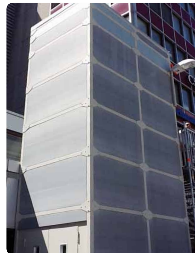
Bauaufzug Blechcassetten aus verzinktem Blech, Gerüststreben grundiert
