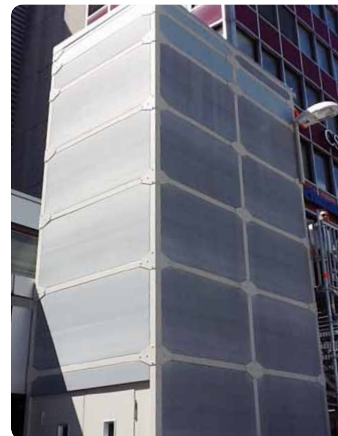
Baufaufzug Blechkassetten aus verzinktem Blech, Gerüststreben grundiert
